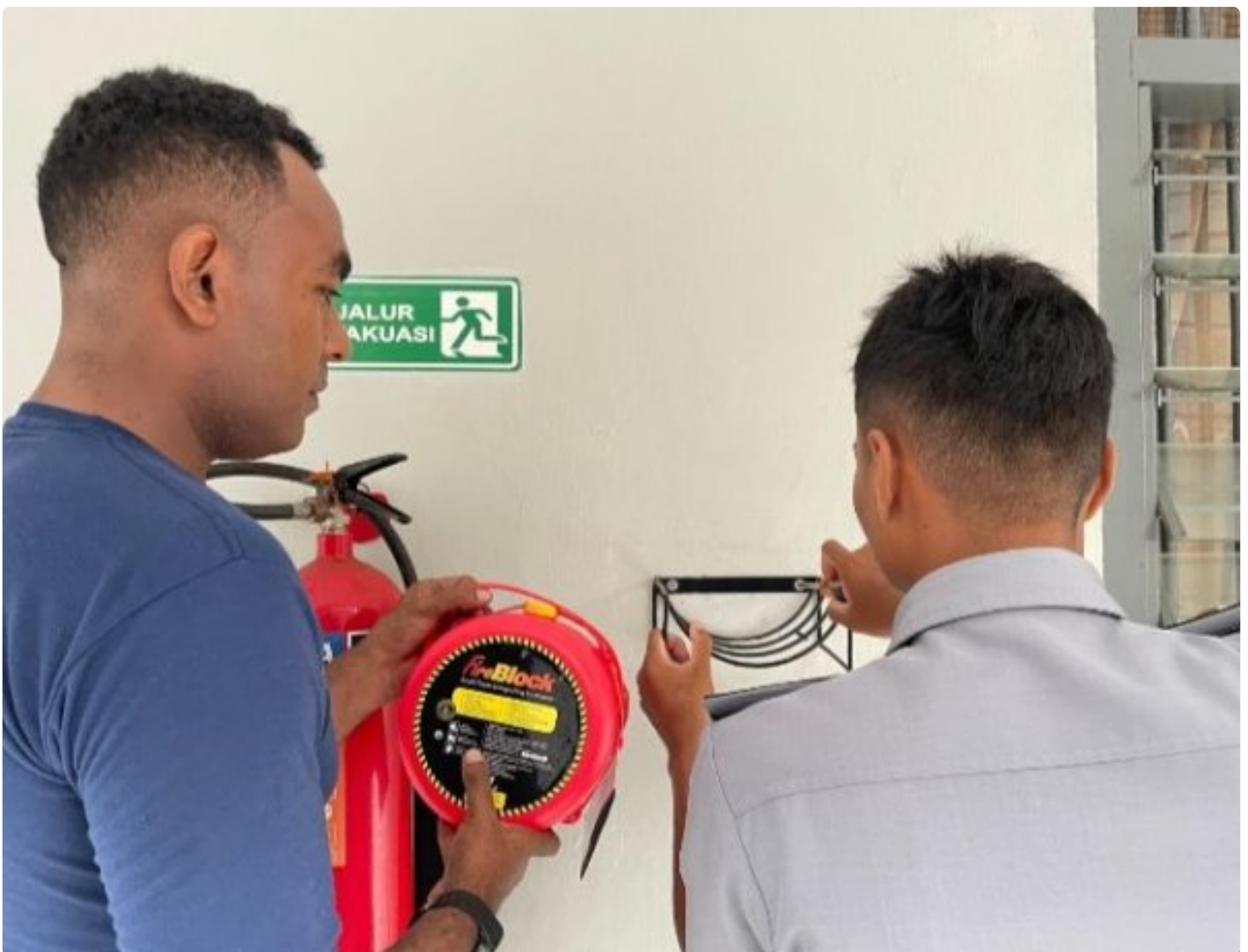
Antisipasi Kebakaran, Lapas Besi Tambah Pemasangan Fireblock
